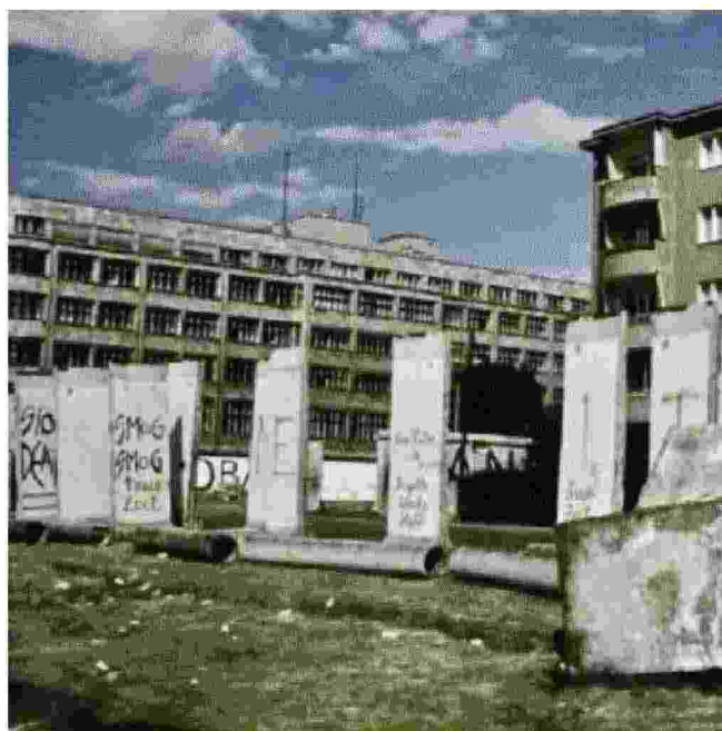
Lo smontaggio dei lastroni del Muro. FOTO ATTILIO PAVIN
